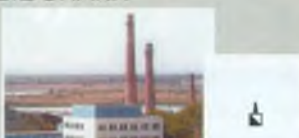
Заводы и фабрики с трубами
