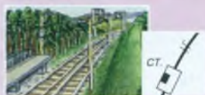
Двухпутная электрифици- рованная железная дорога. Станция
