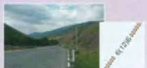
Автодорога с покрытием (6 — проезжая часть, 12 — ширина с обочиной в метрах, Б — бетонное покрытие), Насыпь
